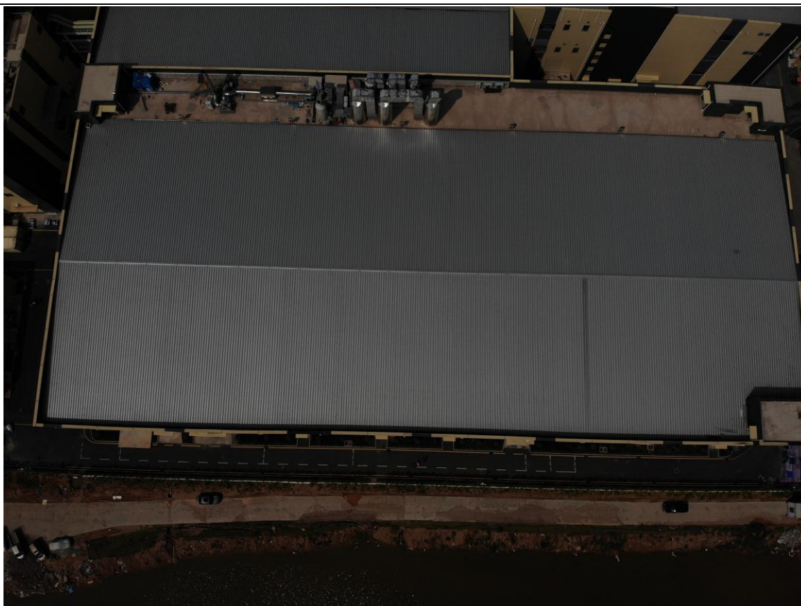
项目区建筑物现状
