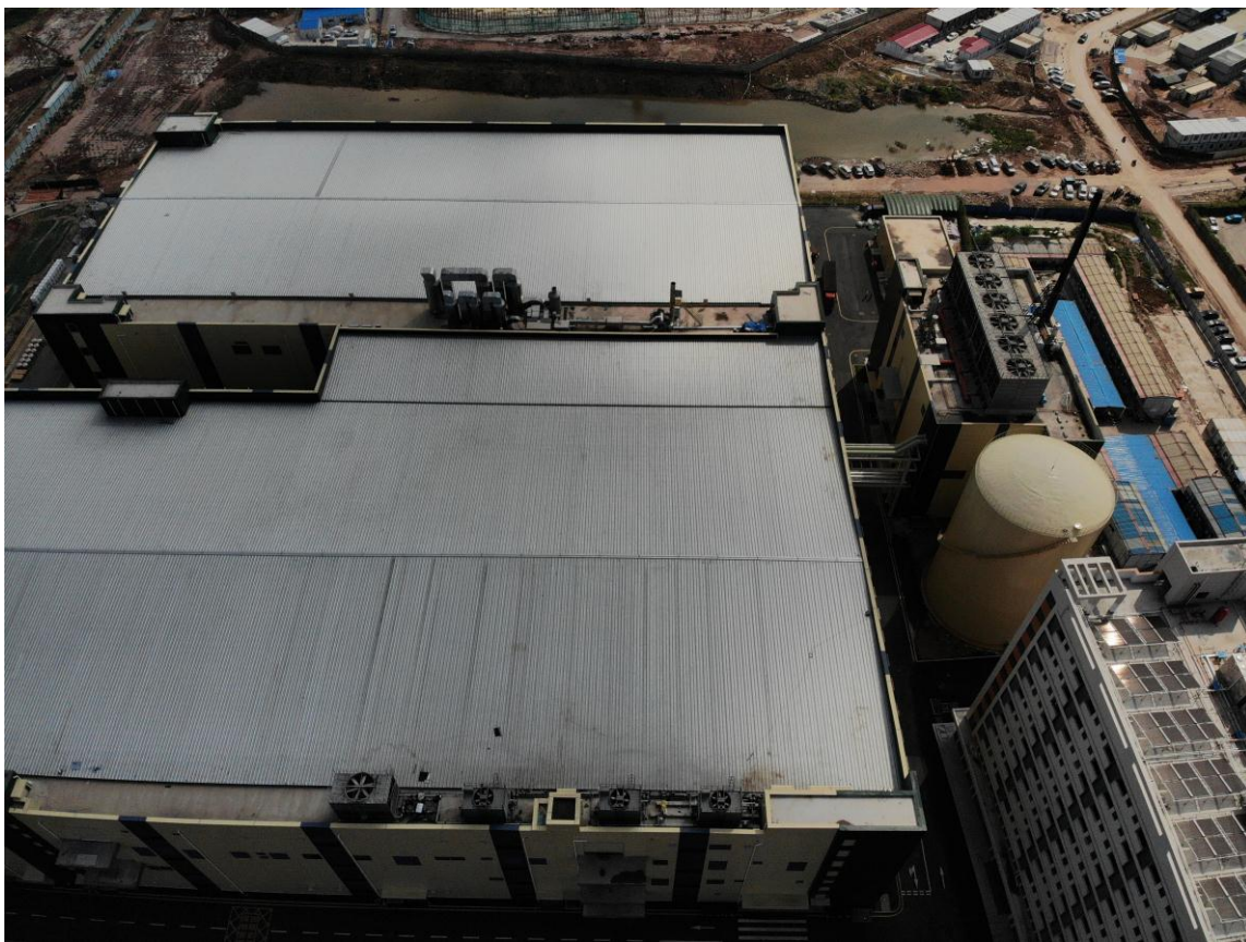
项目区建筑物现状
